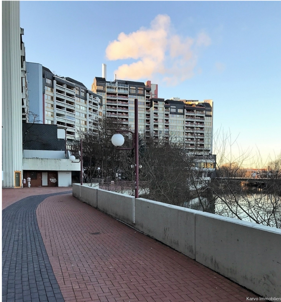
Objekt: CK2026305 | 30449 Hannover
